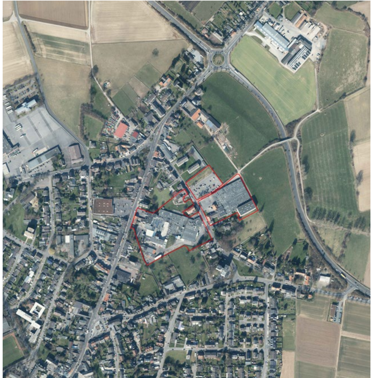
Luftbild des Wettbewerbsgebiets mit drei Teilbereichen in Broichweiden
