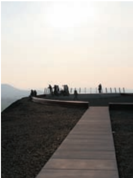
BergFoyer und Schwebesteg im CarlAlexanderPark, Baesweiler Foto: Martin Richardt, Planungsbüro DTP, Essen
