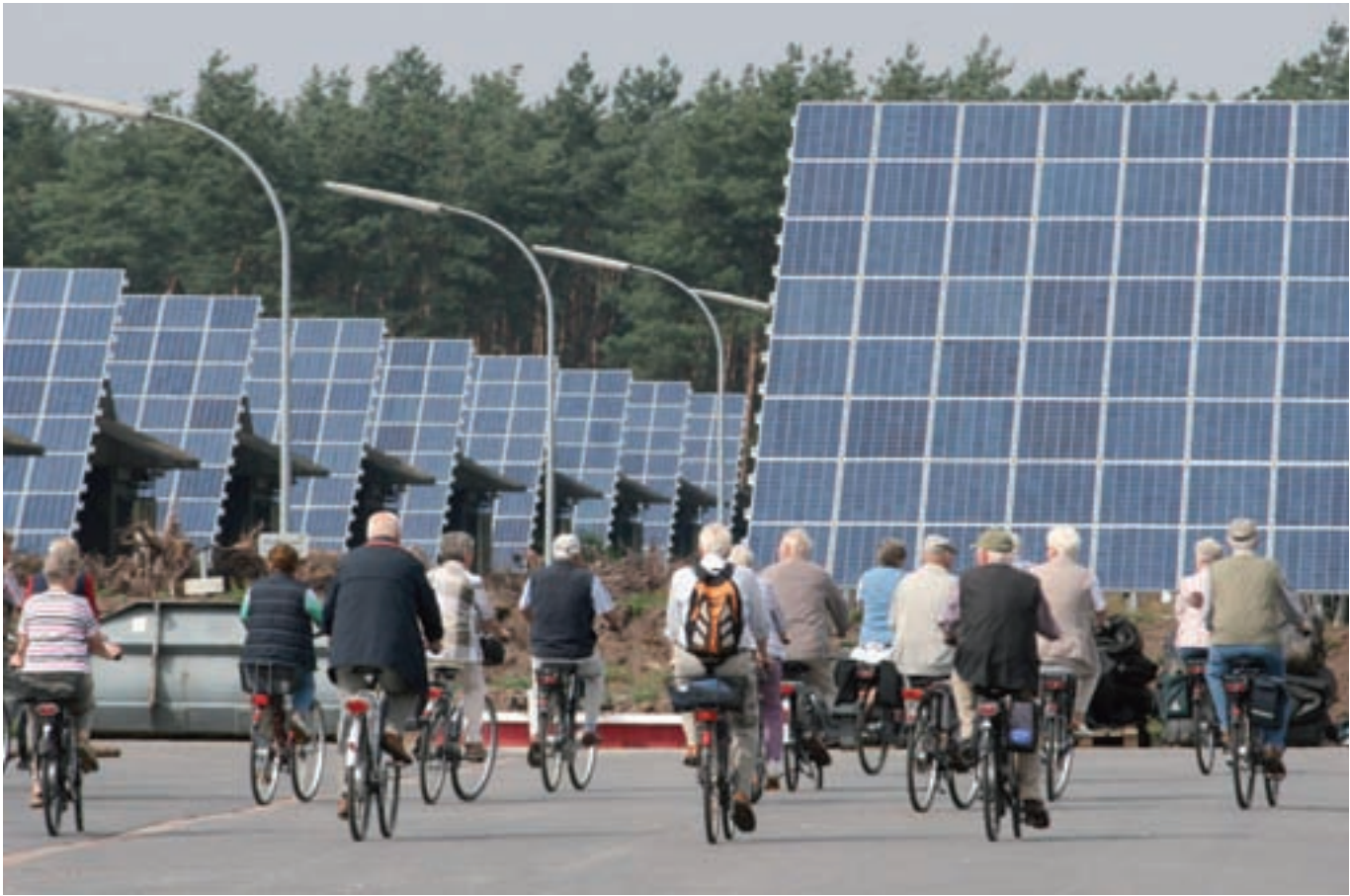
Photovoltaikanlagen im Bioenergiepark, Klimakommune Saerbeck
